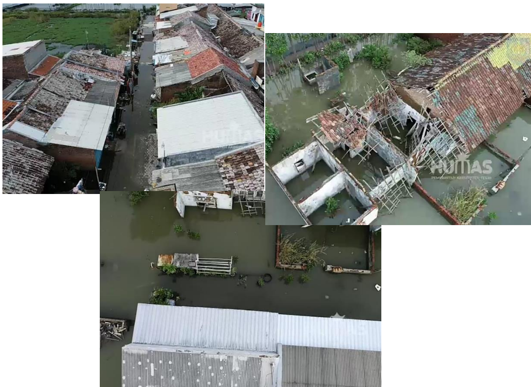
Gambar : Kejadian rob di Kelurahan dampyak Kec.Kramat Kab.Tegal
