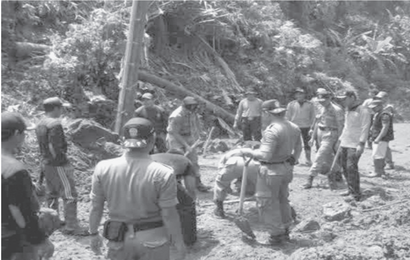
BERSIHKAN MATERIAL - Anggota Satpol PP dan tim SAR Gabungan kerja bakti membersihkan material lumpuran longsor di Muncanglarang
