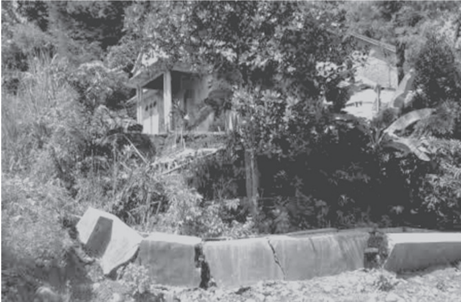
AMBROL- Salah satu rumah yang jadi korban tanah longsor dan jalan yang ambrol.
