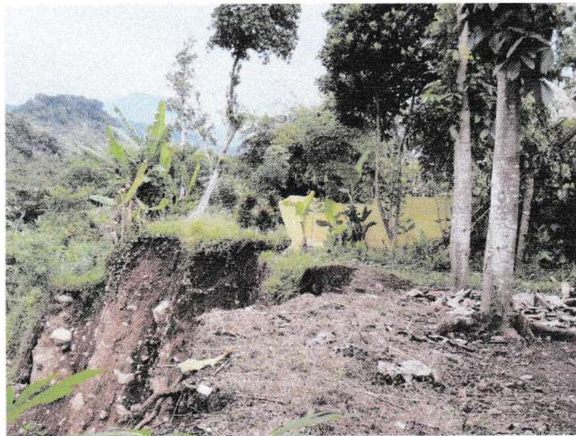
Foto 4. Longsoran di tebing sungai yang terletak dibelakang rumah warga, pada kelokan Sungai Gung. Kenampakan litologi endapan aluvial yang menjadi tempat didirikannya pemukiman warga.
